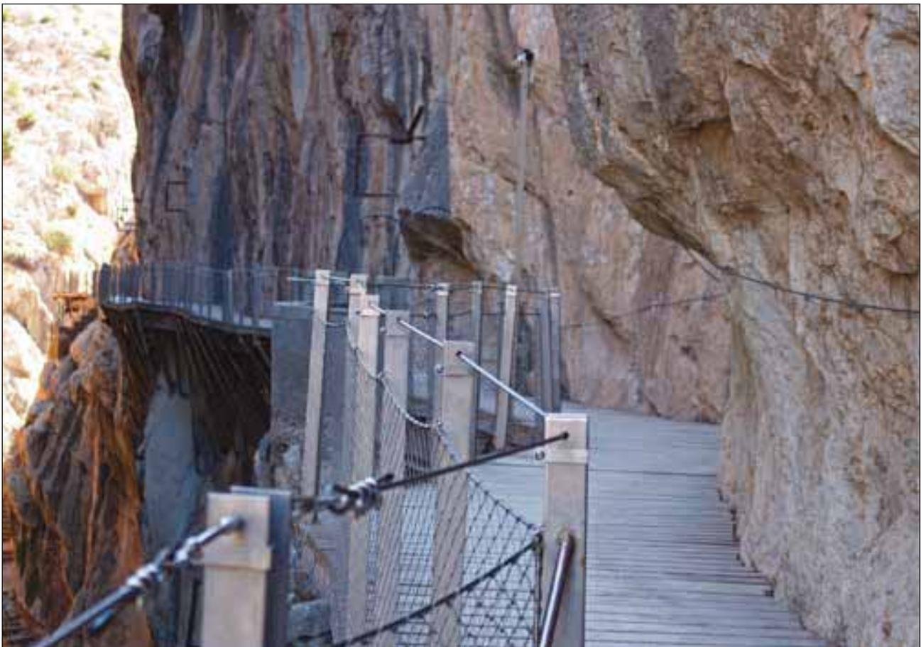
*Barandilla construida con cable trenzado, malla y pletinas verticales, de acero inoxidable en el Caminito del Rey en Málaga*
