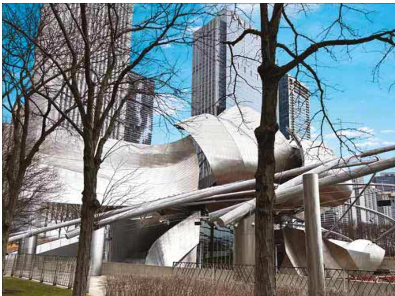
Cubierta de edificio de acero inoxidable en Chicago (Estados Unidos).
