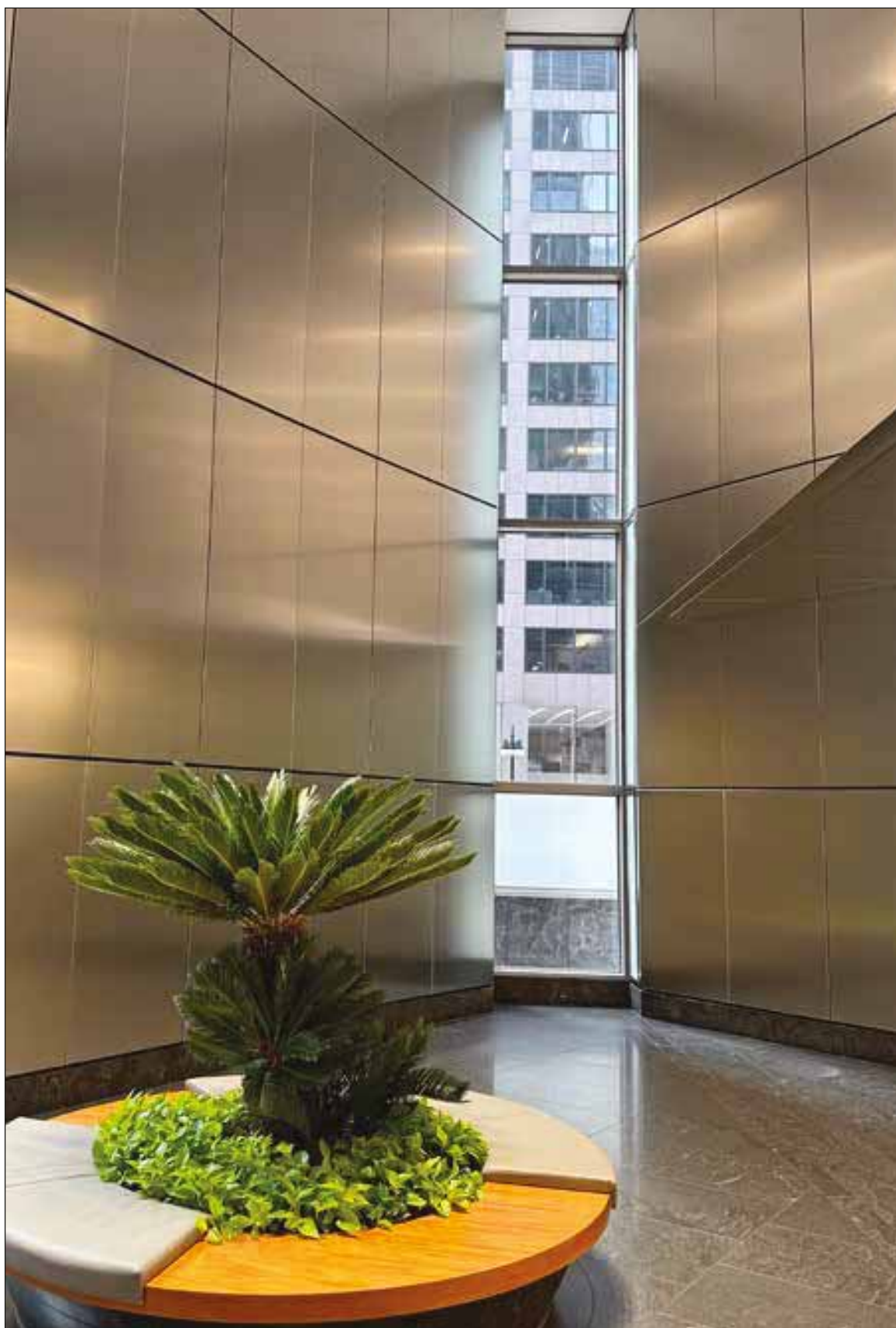
Revestimiento de acero inoxidable en paredes en edificio de oficinas
