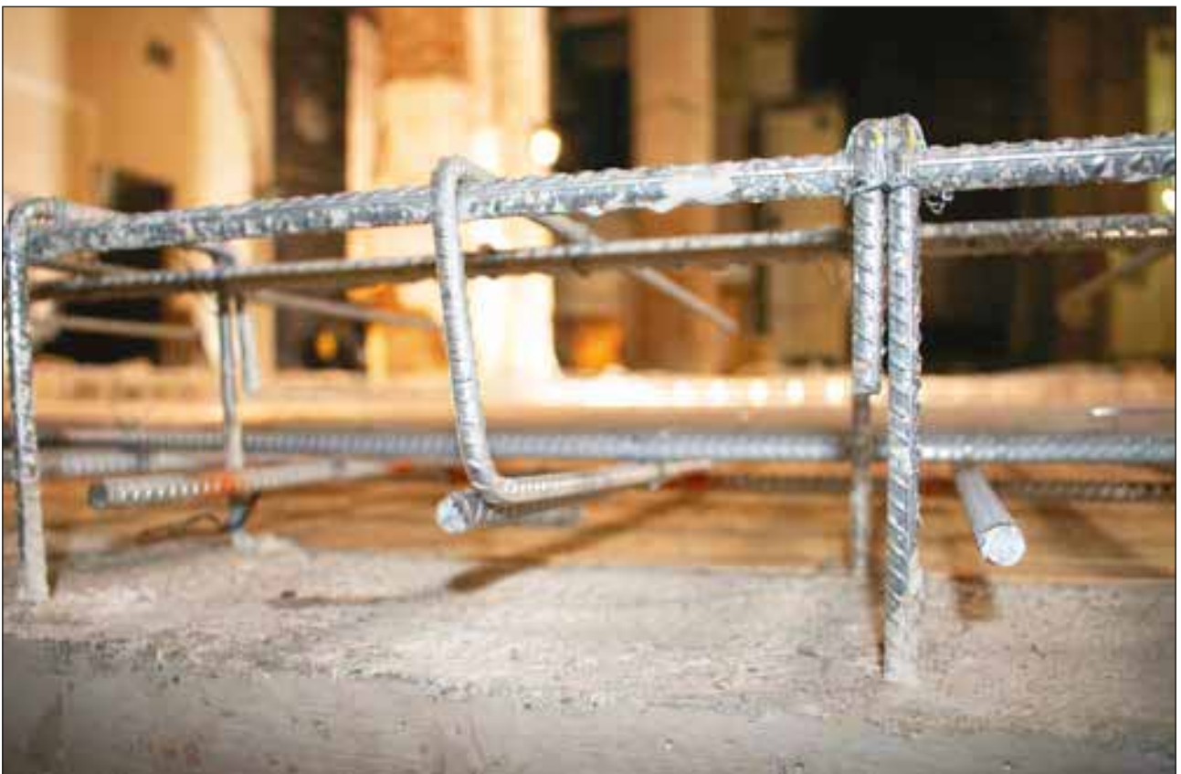
Acero inoxidable corrugado fabricado por Roldan, utilizado en la rehabilitación de la Iglesia de Santa Catalina de Sevilla (España).
