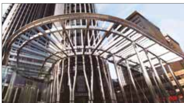
Construcción e Infraestructuras
