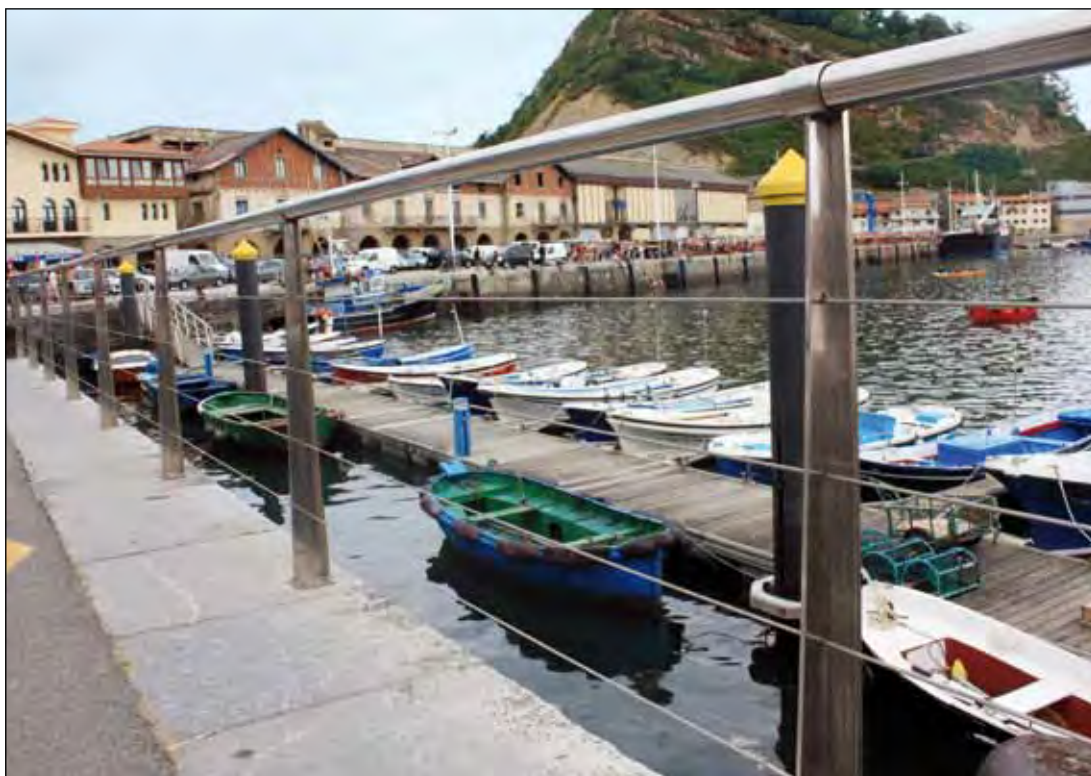
Barandilla de acero inoxidable junto al mar.
