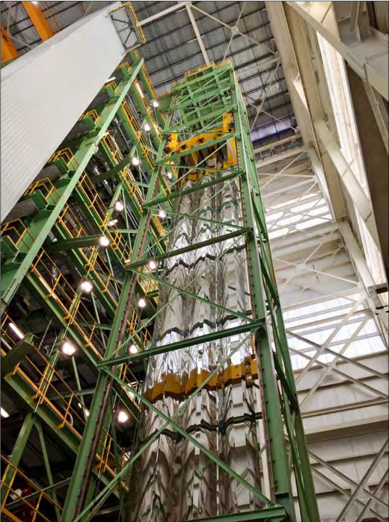
Interior Torre BA en NAS.
