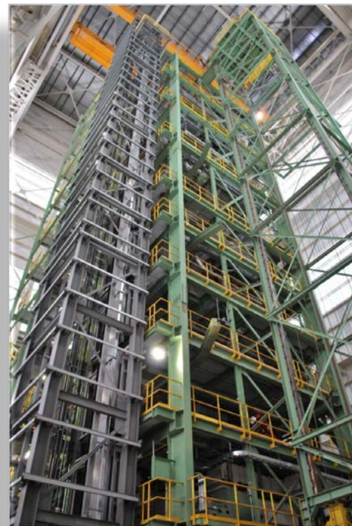
Construcción línea acabado brillante
