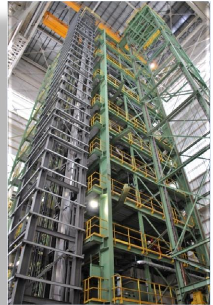
Construcción ZM, NAS
