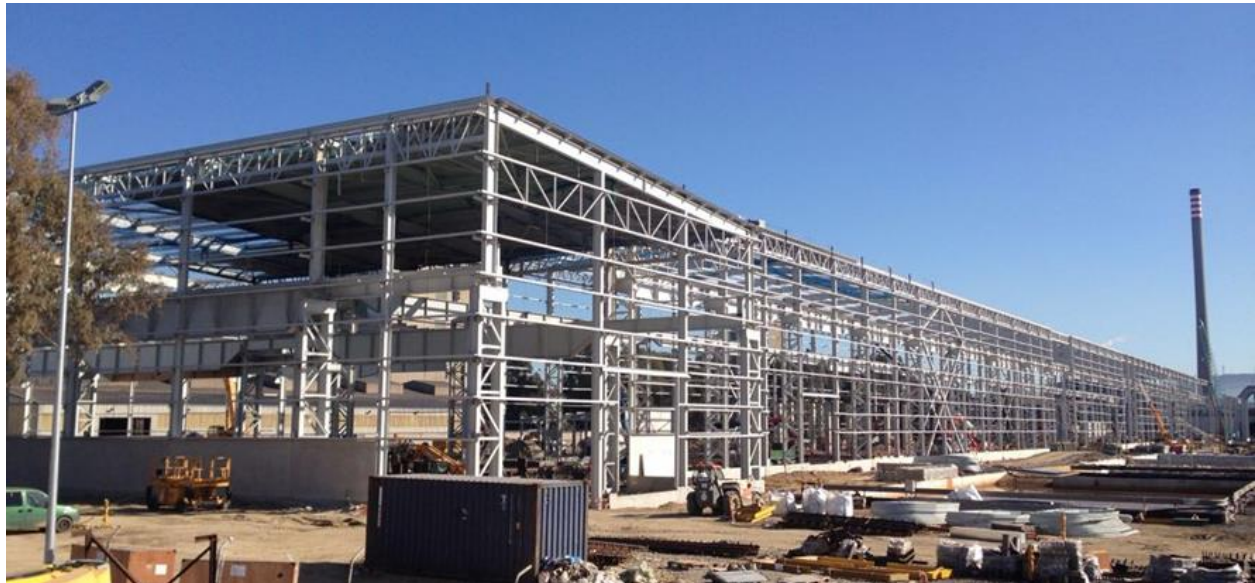
Construcción AP5, Acerinox Europa
